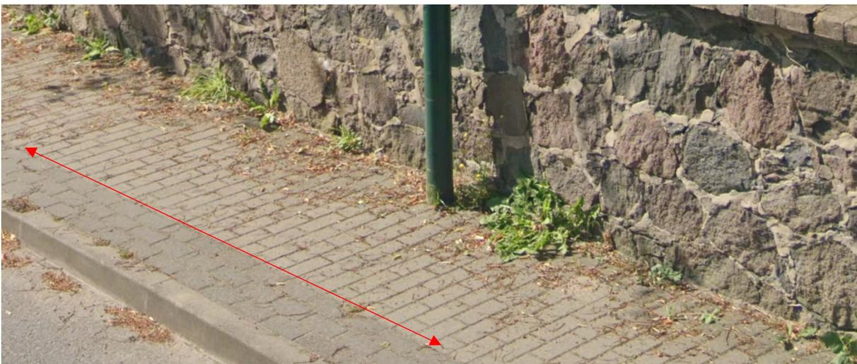
Das Systemgeländer muss mindestens 0,30 m von der Fahrbahnkante entfernt aufgestellt werden, d. h. entlang der 3. Reihe des dunkelgrauen Pflasters.
